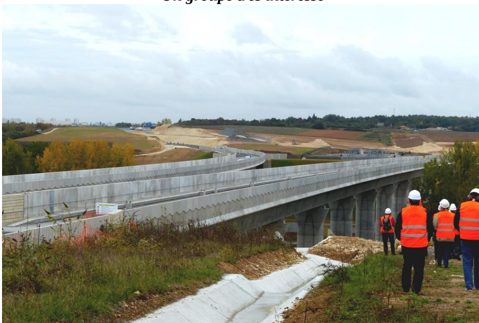
Les viaducs de l'Auxance.
