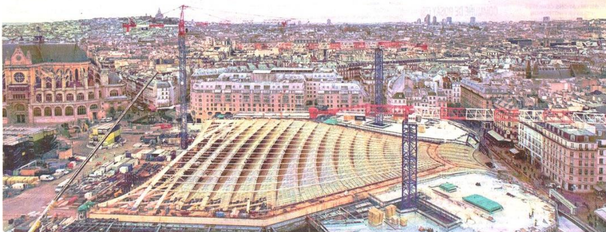
Paris, Forum des Halles (1 er ). La Canopée vue du ciel : la verrière jaune étend sa toile sur 2,3 ha. Ecrasante pour certains, étonnante pour d'autres, la structure de 7 000 t d'acier ne laisse pas les passants indifférents. (Cronos/Chris Knoch, Reuters)
