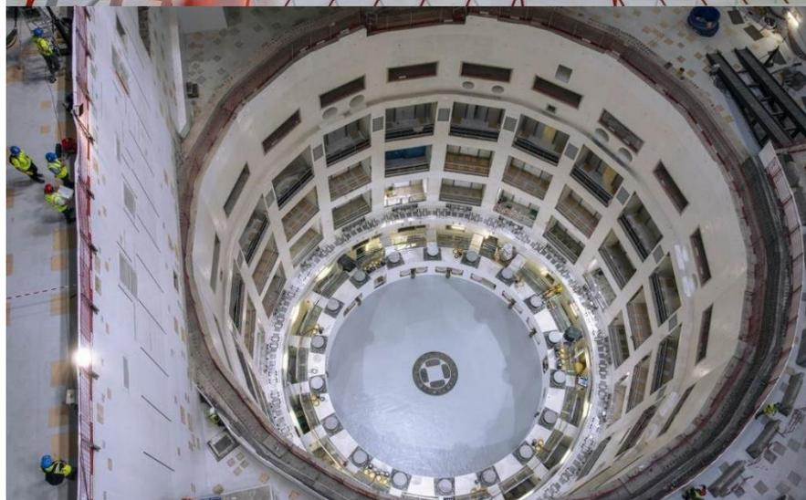
Elle est mise en place dans sa fosse à l'intérieur du cylindre de béton. L'ensemble représentera tout assemblé un cylindre de 30m de haut sur 30m de diamètre et 1250 tonnes.
