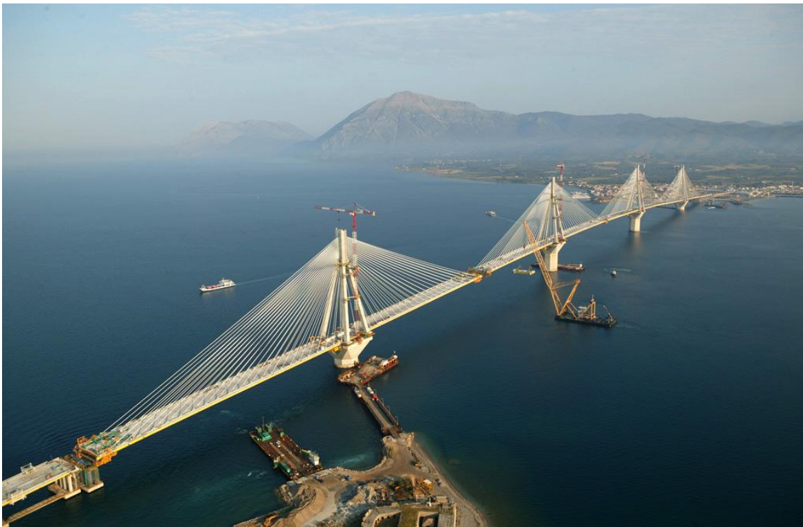
Pose du dernier élément de tablier en mai 2004
