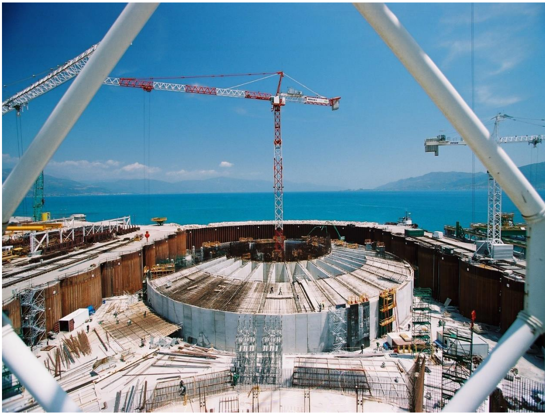
Un caisson de fondation en construction dans la cale sèche
