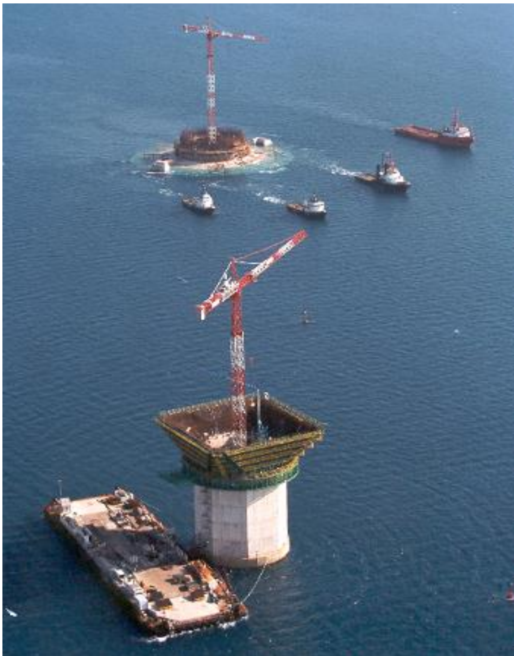
La première pile s'élève. A l'arrière le remorquage du deuxième caisson
