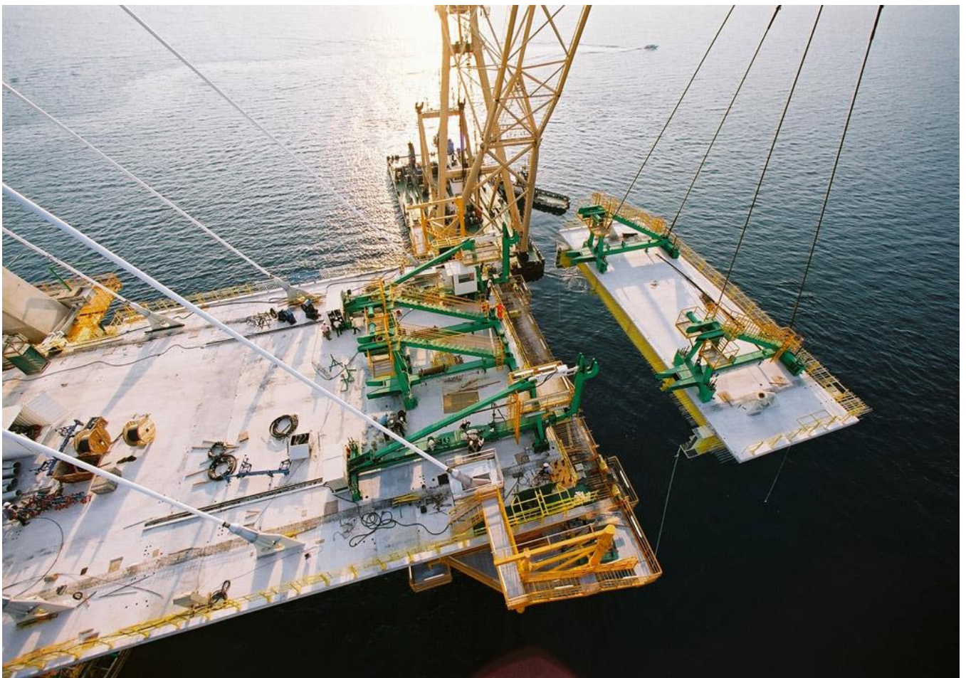
Pose d'un élément de tablier
