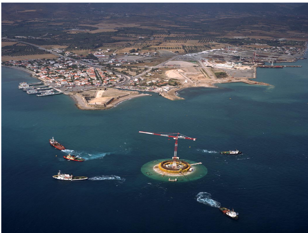
Remorquage du premier caisson vers la cale humide
