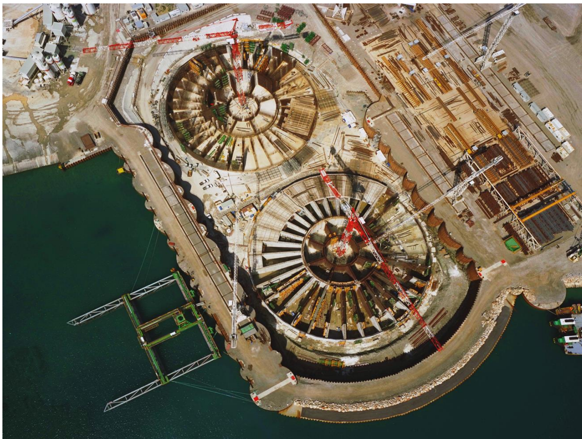
Vue de la cale sèche (100x200) avec les deux premiers caissons
