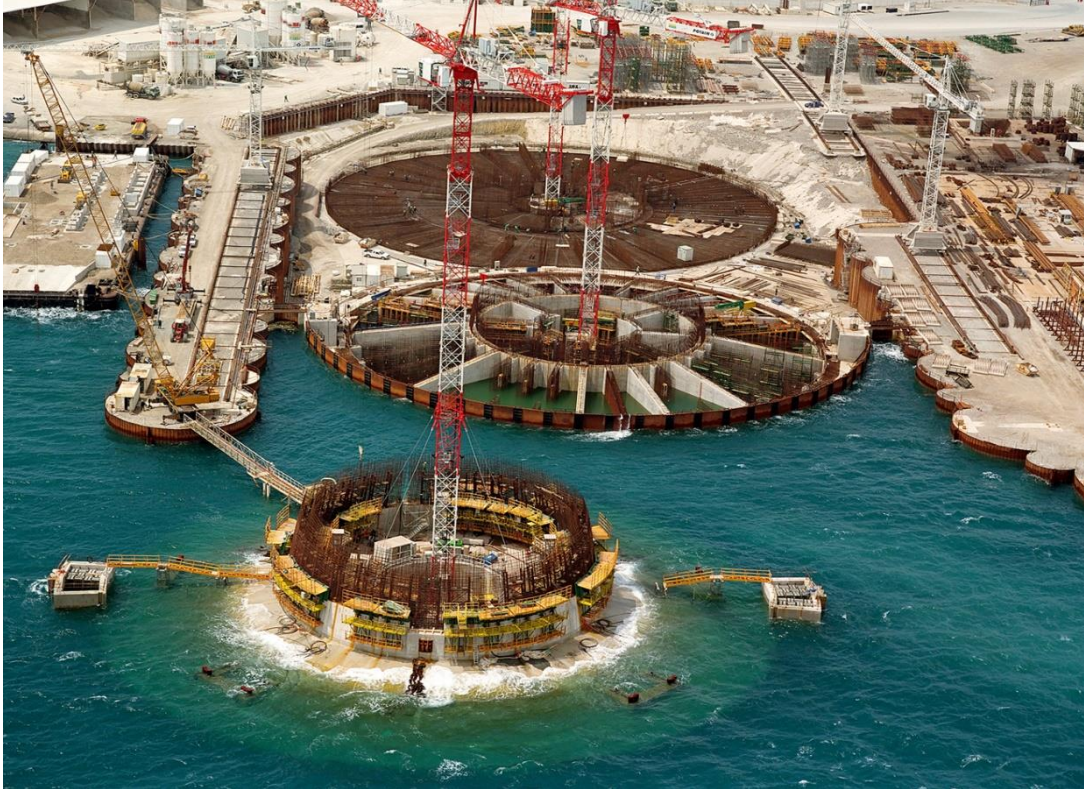
La cale sèche avec deux caissons en construction (celui de devant servant de bateau-porte) et un caisson en flottaison attendant son remorquage
