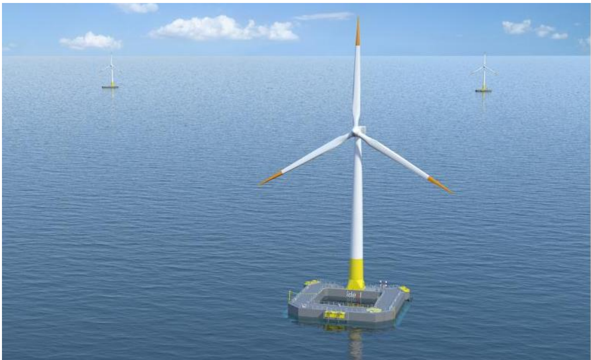
Projet EOLMED (Gruissan) – Flotteur type radeau en béton
