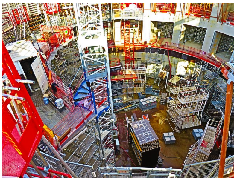
Partie enterrée du bâtiment Tokamak
