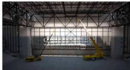
Mise en place du mur manteau
