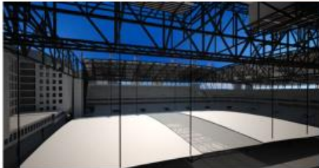
Hissage de la partie centrale de la toiture
