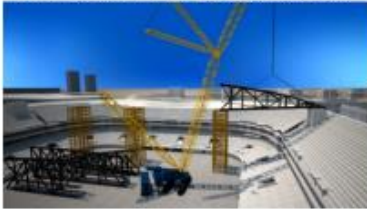
Mise en place de la méga poutre SUD
