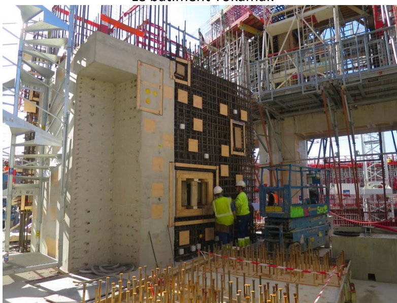
Des épaisseurs de béton et une densité de ferrailage impressionnantes
