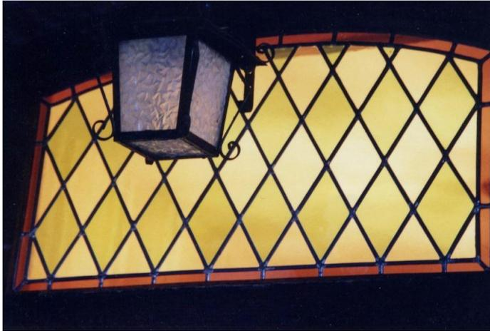
Vitrail géométrique au plomb modèle losange placé en imposte sur une porte d'entrée
