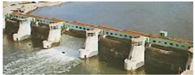
Barrage de Marckolsheim sur le Rhin
