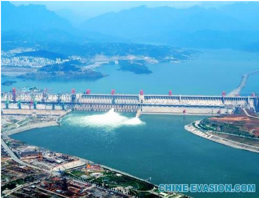
Barrage des Trois Gorges en Chine
