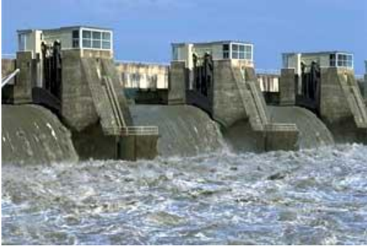
Barrage de Rochemaure sur le Rhône
