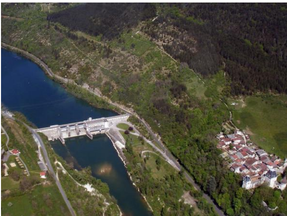
Barrage d'Allemand sur l'Ain
