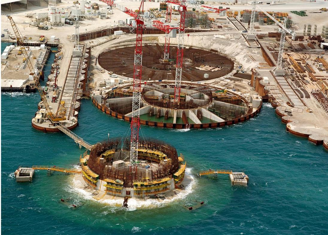
*La cale sèche avec deux caissons en construction (celui de devant servant de bateau- porte) et un caisson en flottaison attendant son remorquage*
