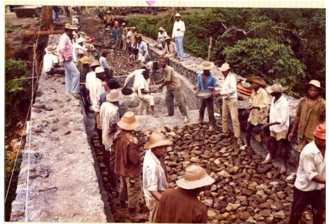
Petit à petit nous avons bétonné les cinq ou six couches de béton et calé les reins de la voûte. Et nous sommes arrivés à la fin du remplissage des deux côtés de la voûte jusqu'au niveau final de la chaussée. Il était temps maintenant de décoffrer la voûte.
